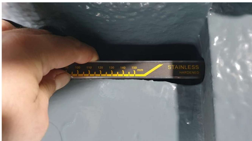
8. ábra: Lánclemezek jellemző képe a lehorgonyzó szelvénynél [8]
