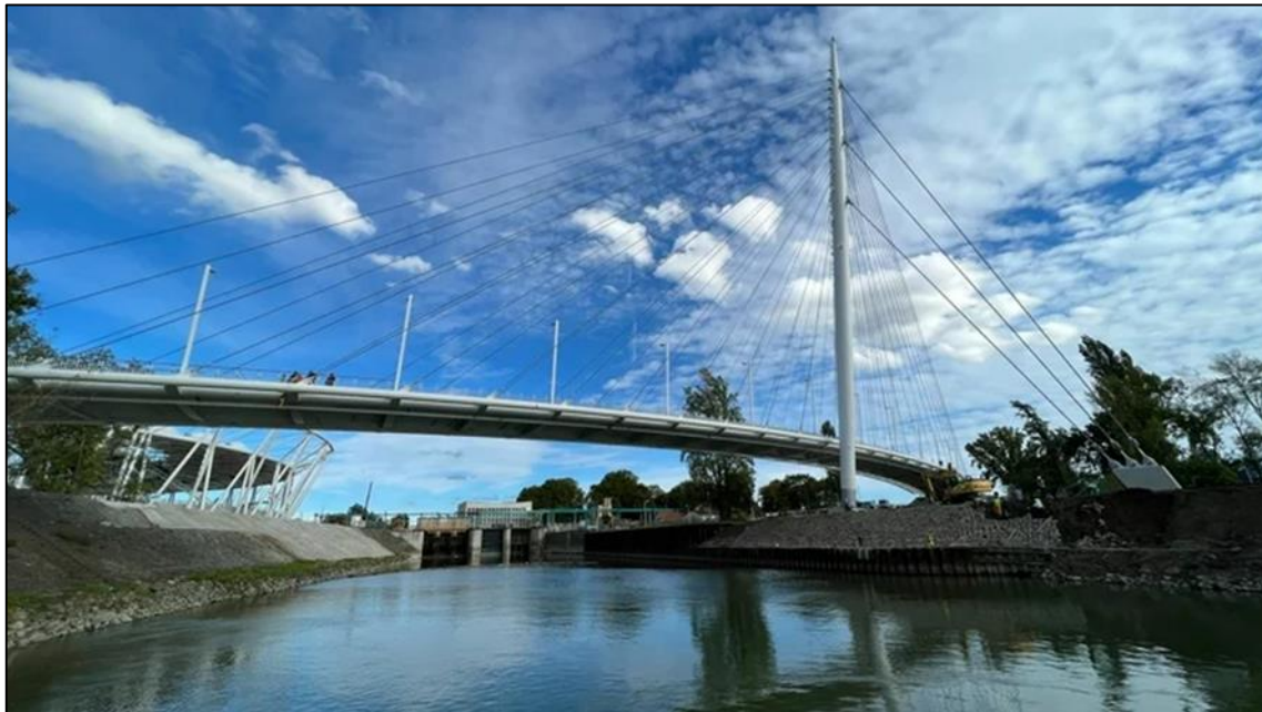
3. ábra: Hídszerkezet a hátrahorgonyzó kábelek bekötésével [3]
