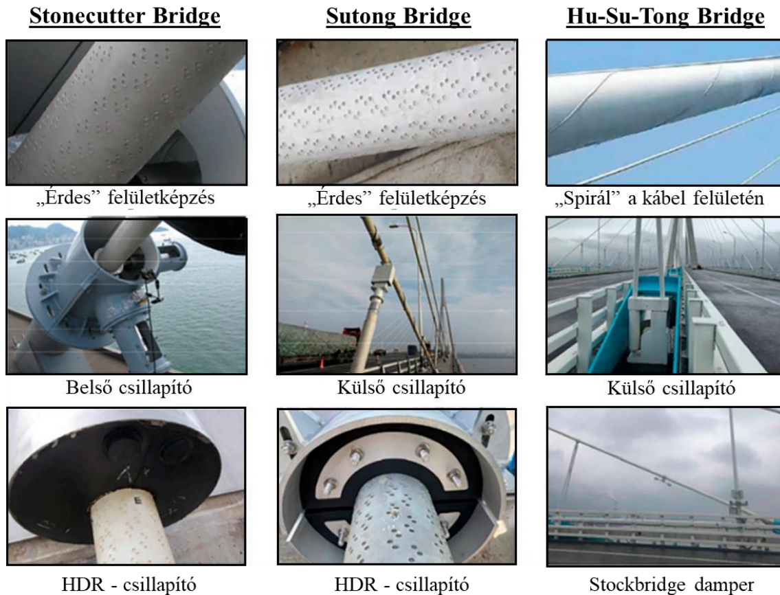
11. ábra: Kombinált csillapítók valós hídszerkezeteken [9 alapján]
