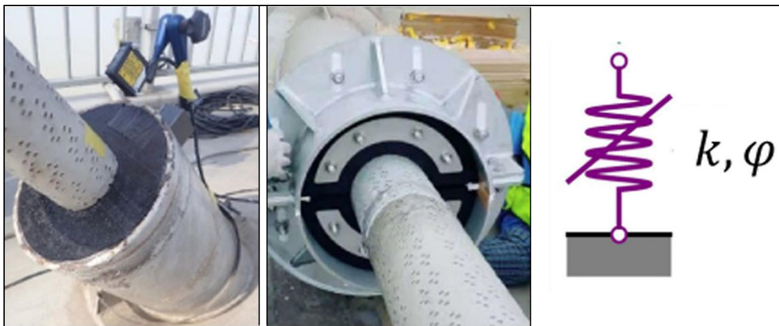
9. ábra: HDR - csillapítók mechanikai modellje és gyakorlati megjelenése [9 alapján]
