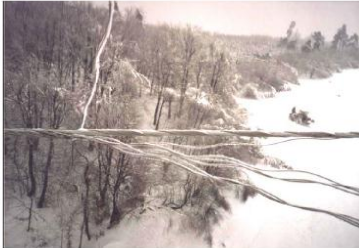
1. ábra. Szálkisodródott védővezető 0
