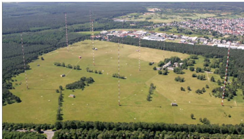
Figure 5: A képen látható oszlopok egy "kábelgyűrűt" tartanak, ami maga az antenna. Adott hullámhosszú rádióhullámot vele összemérhető nagyságú antenna képes sugározni, ezért nagy antennára van szükség.
