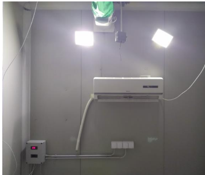
4.6. ábra A légkondicionáló működik, de a szellőztető rendszer nem cseréli ki megfelelően a levegőt
