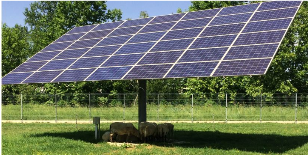
6.1-1. ábra: Egy egység 42 db panel napkövető mechanikával és inverterrel
