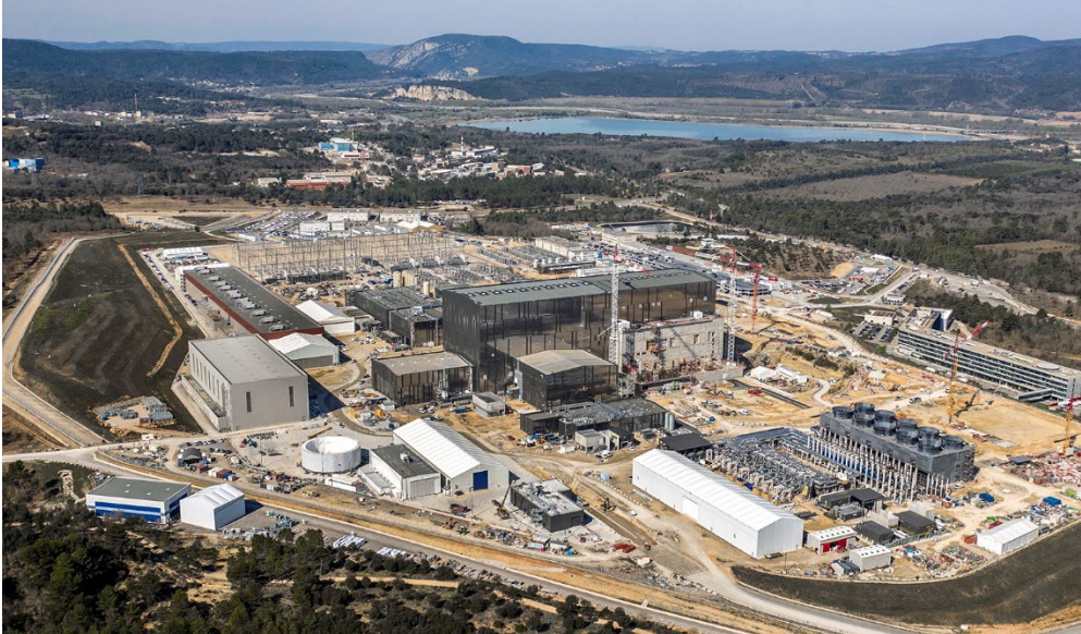
6. ábra: Az ITER építési területe a franciaországi Cadarache közelében [4].
