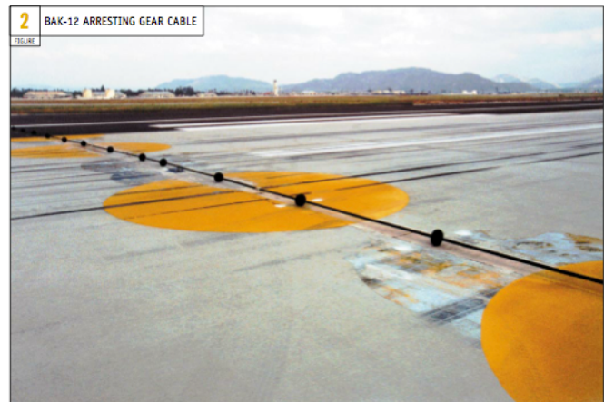
20. ábra: Földi alkalmazású telepített fékező kábel. [18]
