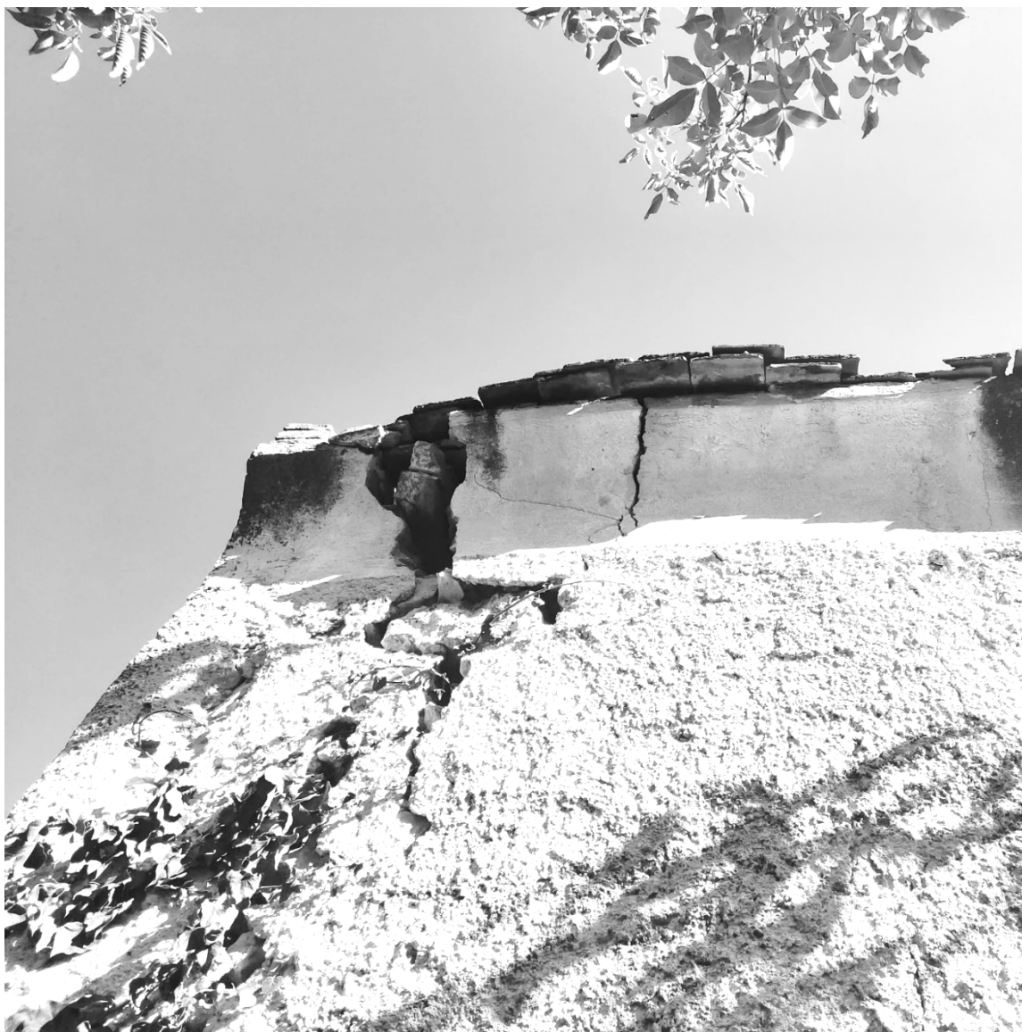
repedezett eresrészlet / kép: saját fotó
