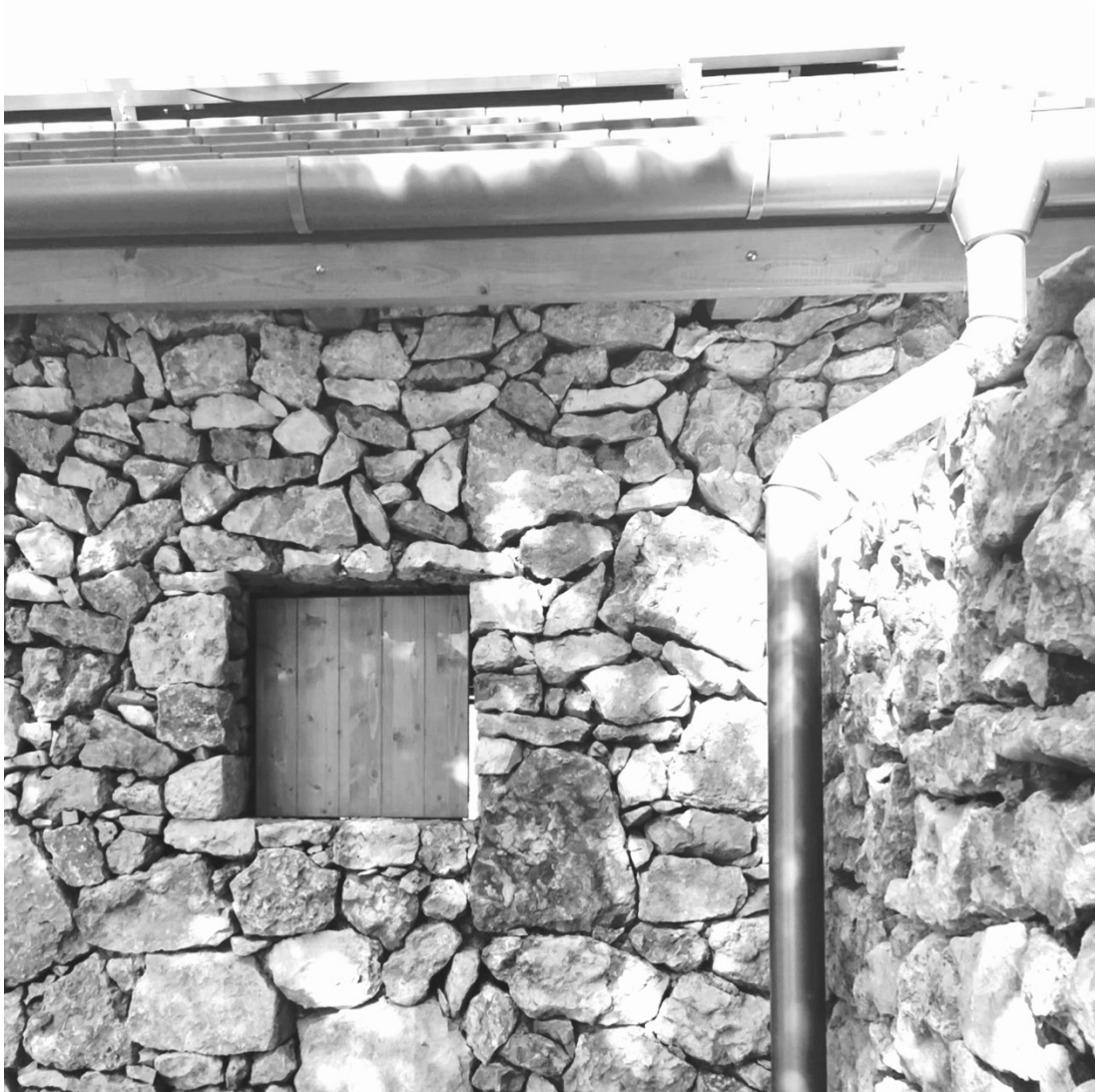
vöröstói pajtaépület felújítása / kép: saját fotó
