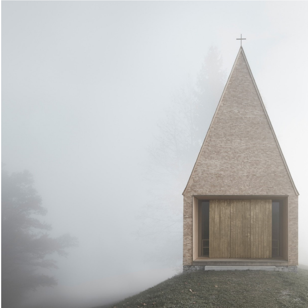
Vorarlberg építészetére jellemző fafedésű homlokzat, az anyag szürkülése előtt. /Kapelle Salgenreute, Bernardo Bader Architekten, Krumbach, Ausztria, 2017 / kép: Adolf Bereuter, bernardobader.com
