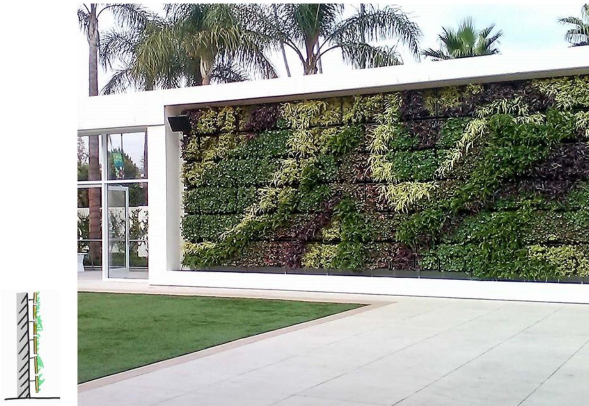
26.ábra: Kazettás zöldhomlokzat
