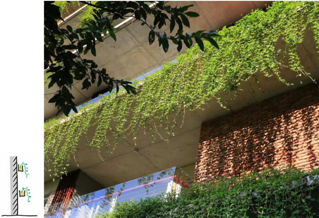
23.ábra: Csüngős növényzettel kialakított zöldhomlokzat
