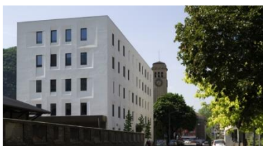
6. ábra: A felújított homlokzatú irodaház
