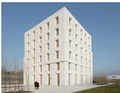
18. ábra: A "2226" irodaház homlokzatai
