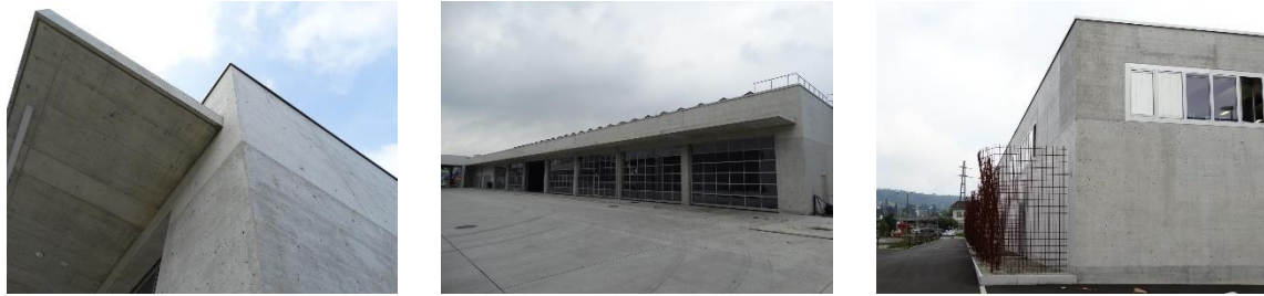
24. ábra Képek a megépült Werkhof Scheidegg épületről [19]
