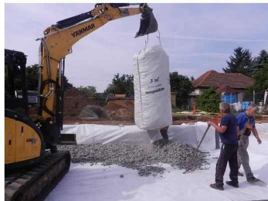
33. ábra Energocell beépítése családi ház lemezalapja alá Vecsésen [25]
