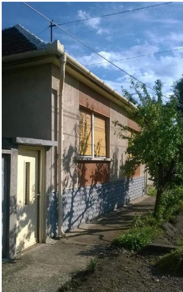
14.1.5 - 6. ábra: Utcai (délkeleti) homlokzat
