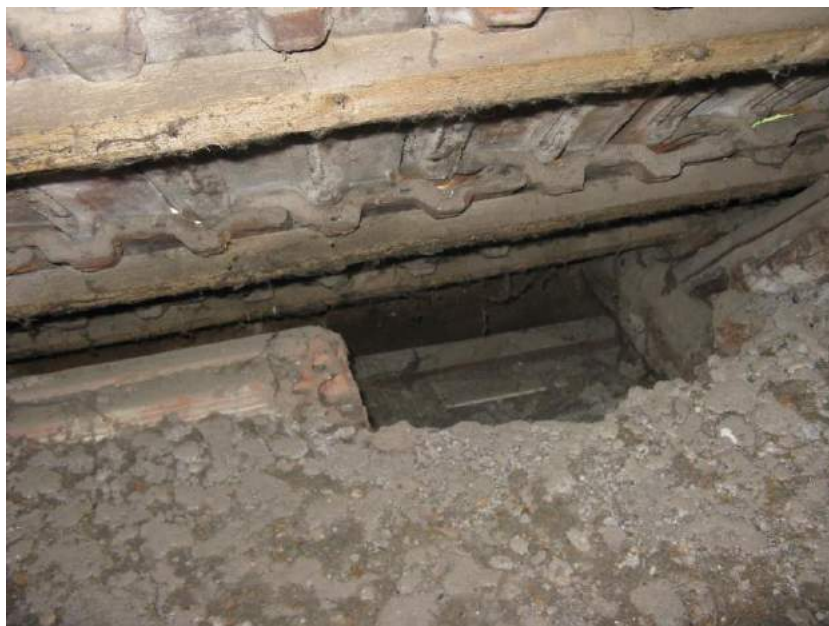
14.1.5 - 4. ábra: Eredeti vasbeton koszorú
