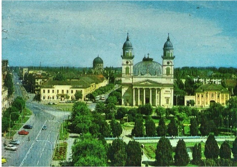
11. A megépített sugárút és a még álló polgármesteri hivatal épülete.
