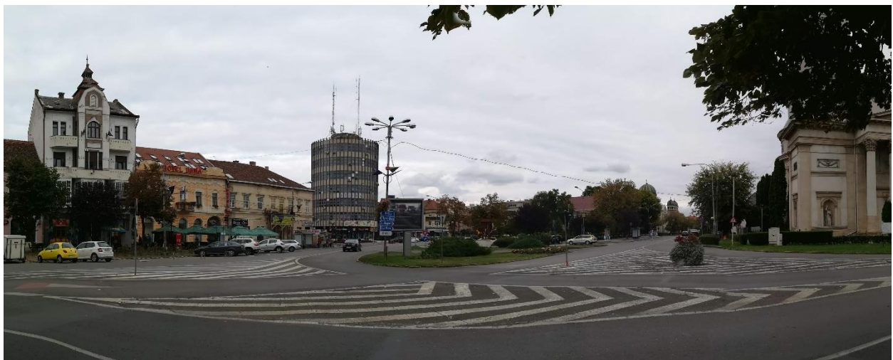
14. A Casa de Moda épülete az elbontott polgármesteri hivatal épületével.
