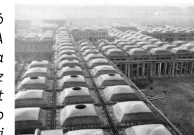
27. kép - kupolák betonozás előtt
