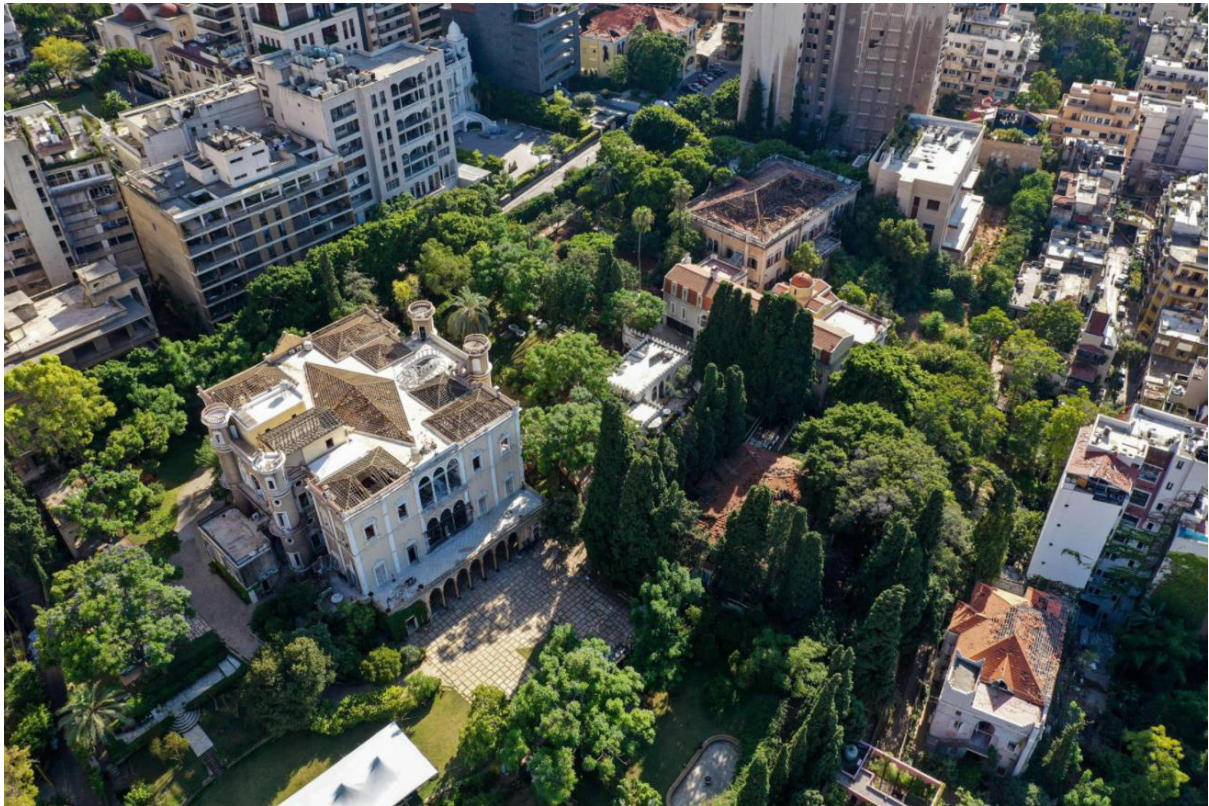
Megrongálódott történeti épület zöld, zárványszerű környezetében 7
