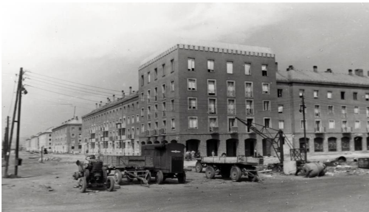
4. Kerepesi úti lakótelep építése, forrás: fortepan.hu
