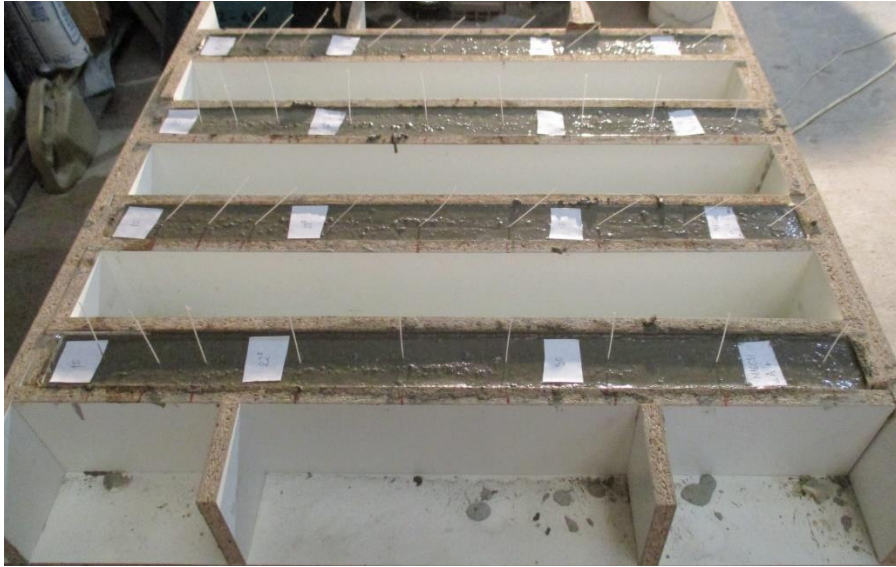
11. ábra: Fotó - Betonozás
