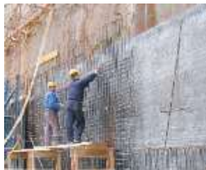
Voltex bentonitos paplan alkalmazása a mélyépítésben [H]
