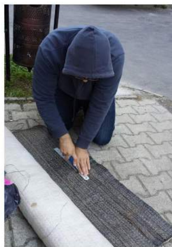
Szigetelések méretre vágása
