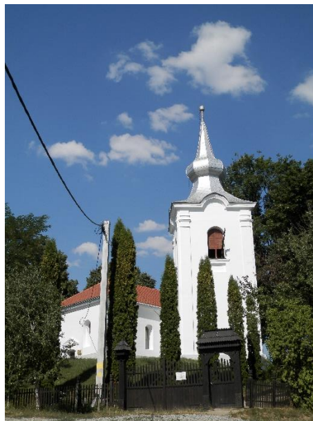
20./H – A rétyi ref. templom homlokzata (délnyugati)
