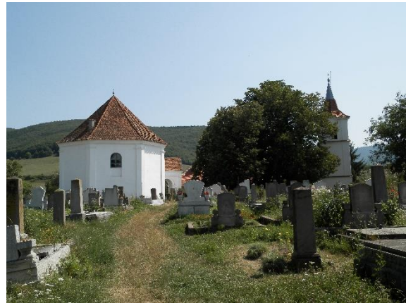
18./H – A málnási ref. templom homlokzata (délnyugati)
