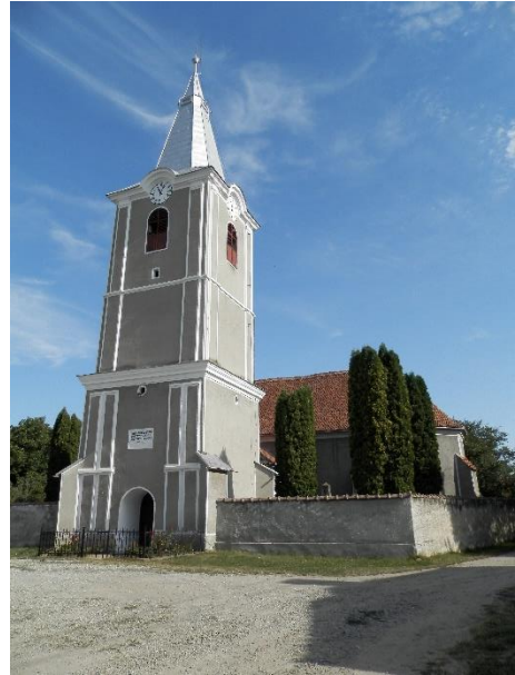
1./H – Az aldobolyi ref. templom homlokzata (délkeleti)
