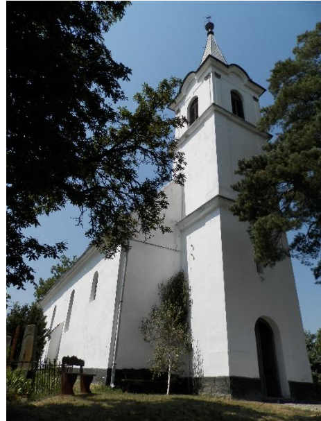
19./H – Az oltszemi ref. templom homlokzata (délkeleti)
