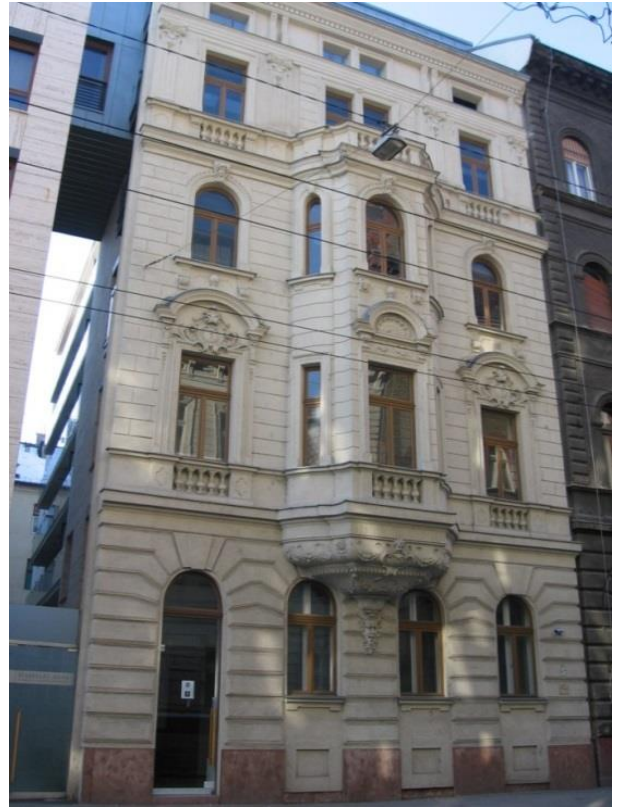
8. kép az Izabella utcai csonka homlokzat
