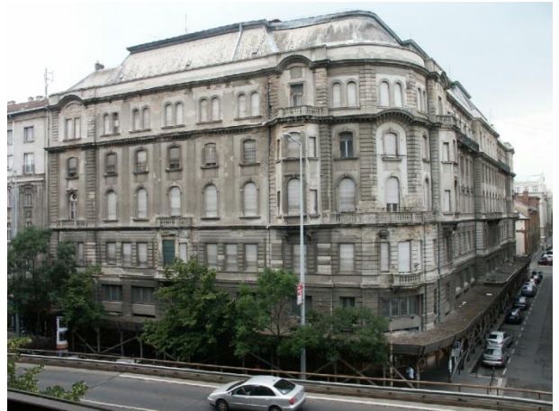
3. kép: az épület a felújítás előtt
