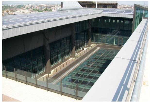
9. kép: a megemelt üvegtető a legfelső eredeti szint magasságában
