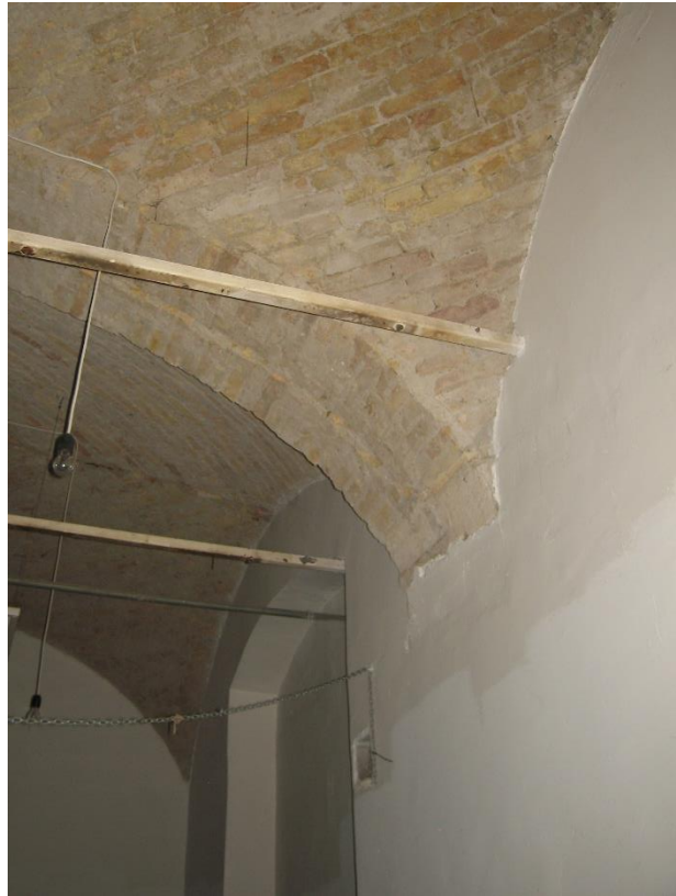
22. ábra: Utcái kéttraktusos rész boltozott födeme (2018)
