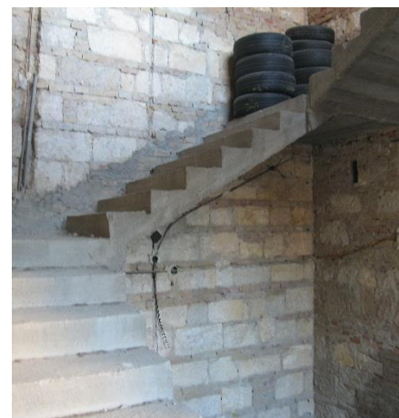
23. ábra: Új vasbeton fölépcső (2018)
