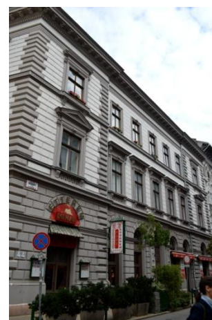
Ráday utca felőli homlokzat
