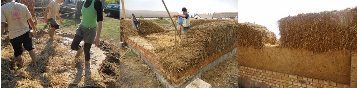
17. ábra – Készülő rakott fal (saját fényképek)
