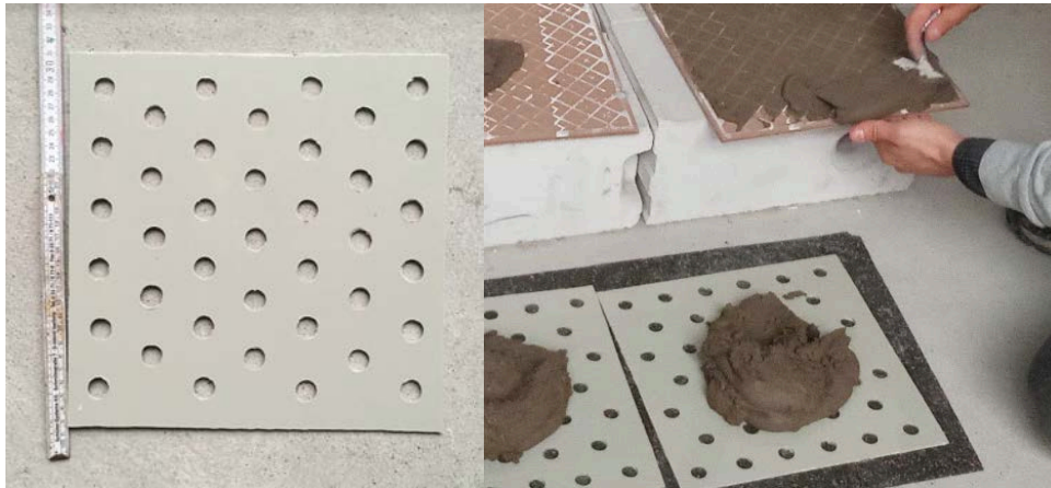
21. ábra: A perforált lemez mintázata és beépítése (a habarcs eldolgozása és a burkolólap beágyazása előtt)
