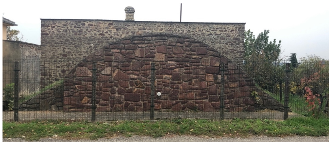
66-73. kép: Révfülöpön előforduló balatonalmádi homokkő – kerítés, homlokzat, borospince
