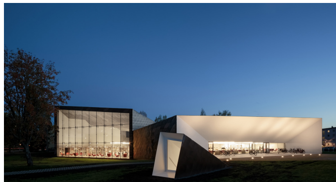
Seinäjoki Library (new)_JKMM Architects_2012_megnyitások
