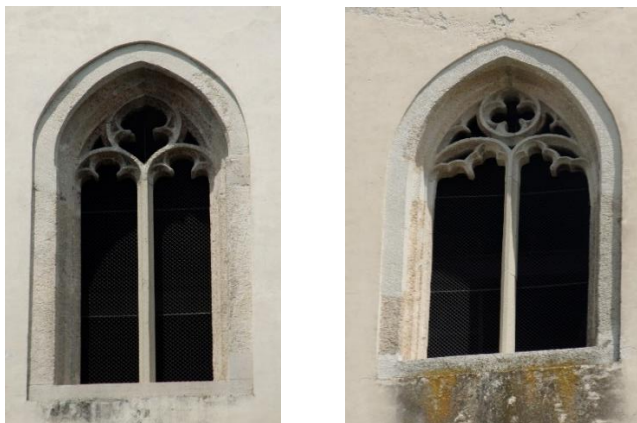
137. kép Szentkirályszabadja. Torony mérműves ablakai
