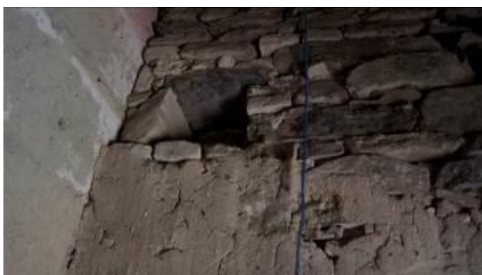
107. kép Vindornyaszőlős. Falcsatlakozás - nyugati torony déli fala (kő) és keleti hajófal (vakolt)
