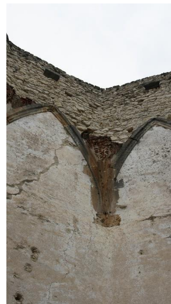
44. kép Nagyvázsony. Boltváll a kolostortemplom szentélyében
