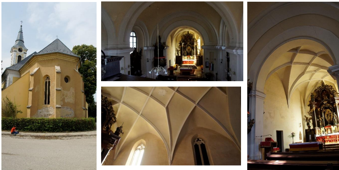
6. kép Törökkoppány. XV. századi szentély mérműves ablakkal. Barokk templomhajó. XV. századi hálóboltozat a szentélyben.
