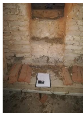
93. kép Balatonszemes. A diadalív falában a szentély felől látható csúcsív maradványa
