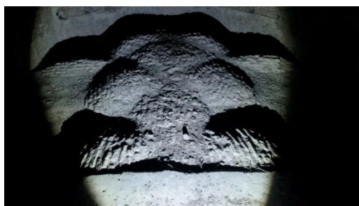
53. kép Törökkoppány. A szentélyboltozat felülről nézve
