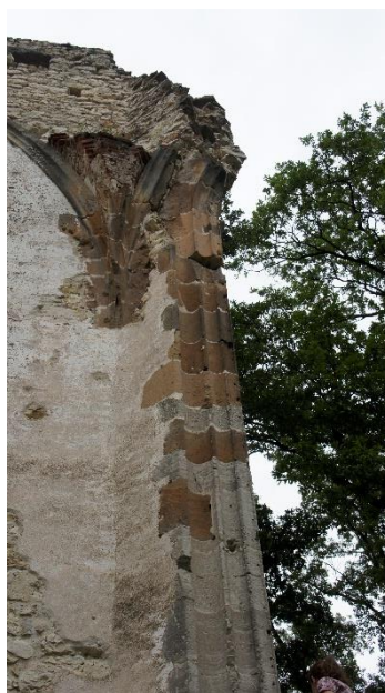
43. kép Nagyvázsony. Boltváll a kolostortemplom szentélyében
