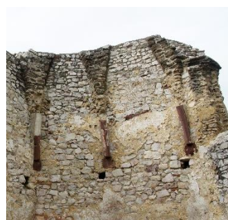
31. kép Balatonfüred. Bordaindítások a szentélyben
