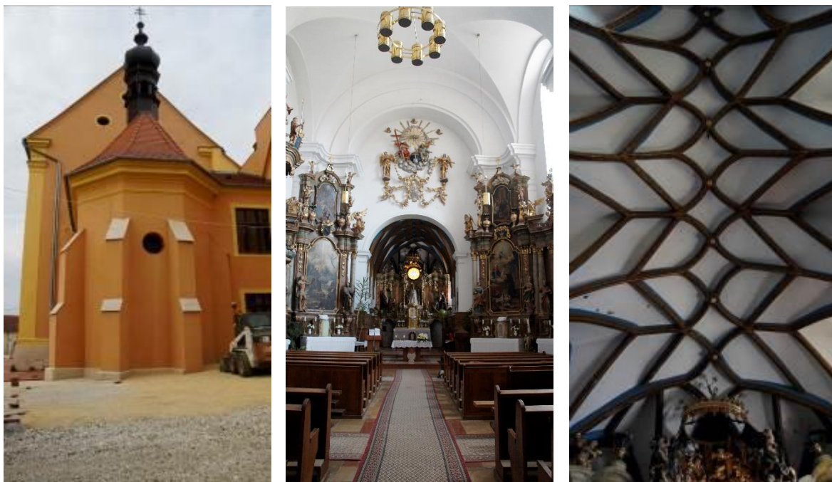
1. kép Andocs. XV. századi szentély, mögötte a barokk templomhajóval; a barokk templomtér; a XV. századi térgörbe bordás szentélyboltozat.
