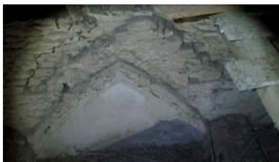
68. kép Kőröshegy. Boltozatok homlokívei a szentély falában
