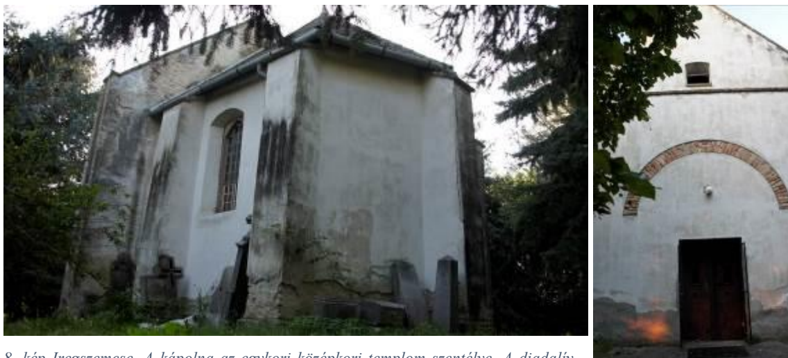
8. kép Iregszemcse. A kápolna az egykori középkori templom szentélye. A diadalív didaktikus jelölése a homlokzaton.
