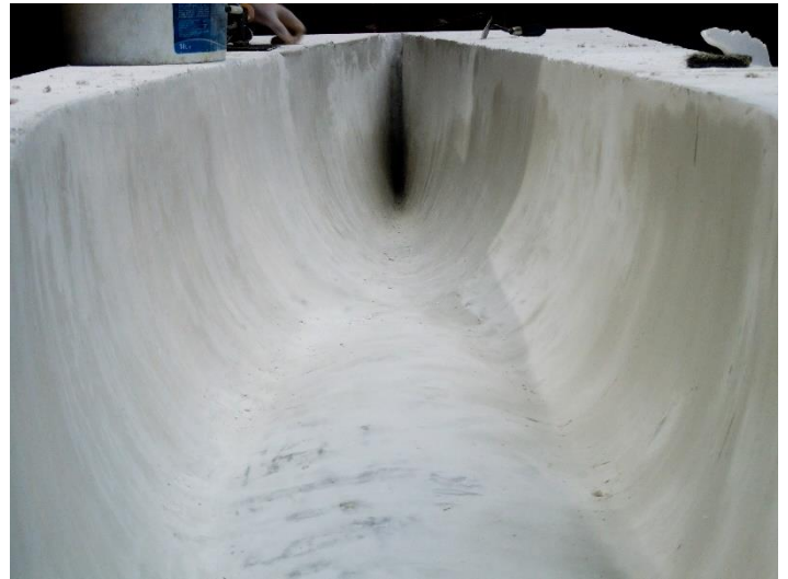
8. kép Az elkészült zsaluzat
