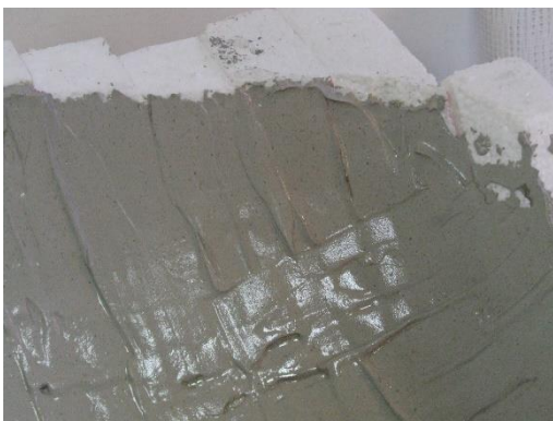
7. kép A próbazsalu gipszezése
