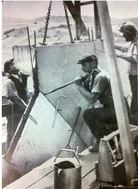
4. ábra Mátrai Gyula: Ajkai hűtőtorony előregyártott elemei (1949)
