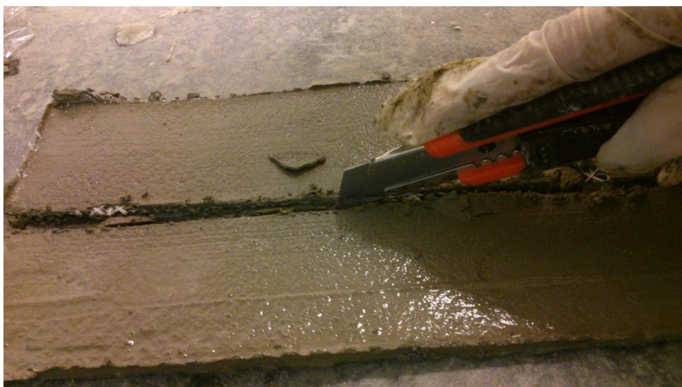
17. ábra Sniccerrel vágható nedvesen
