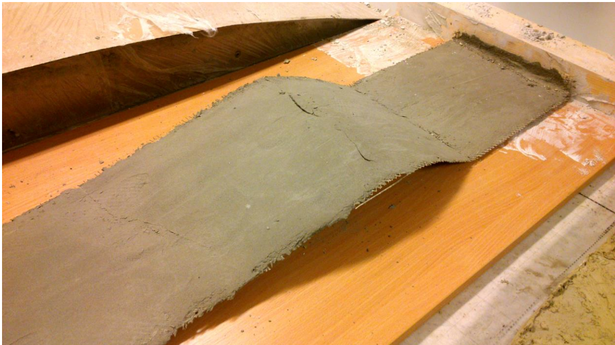
24. ábra Monolit ív horpadása
