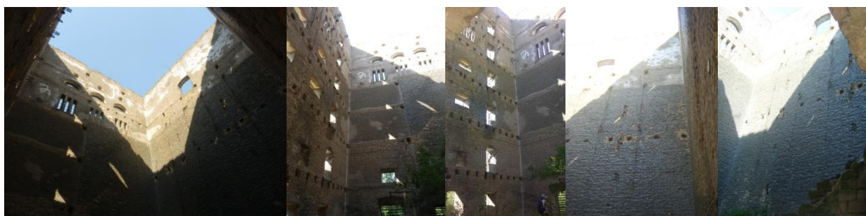
34. A kiégett elevátor belülről ma: üres ablaknyílások és az egykori szerkezet helyének maradványai a falban
