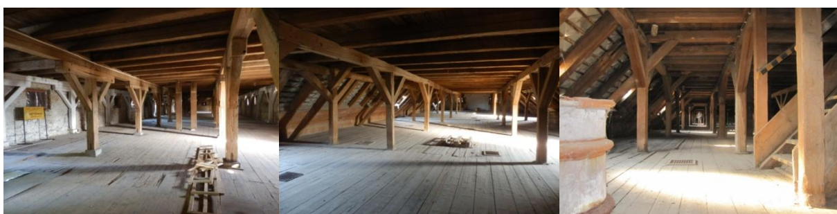
30. A központi magtár belső fa szerkezete: földszint és az alsó tetőtéri szint
