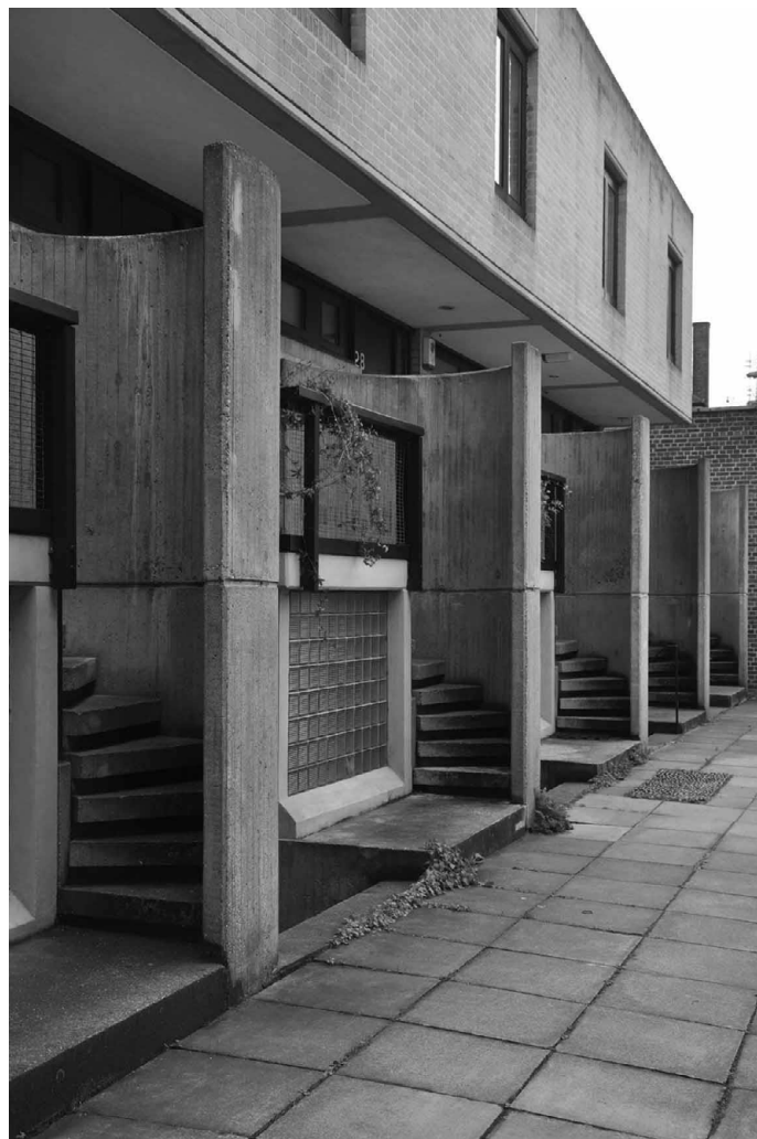
4.3.3 Wunscombe Street, beton csigalépcső és üvegtégla bevilágító
