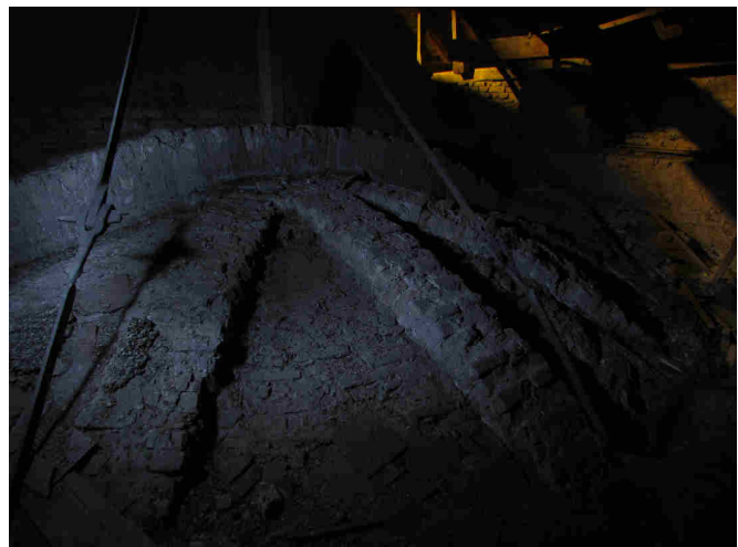
14. kép: A soroksári templom boltozata a szentély felett (saját fotó)
