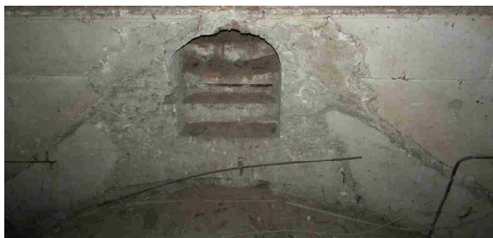
23. kép: A lorettói kápolna eredeti fedésének nyoma a később épült templom falazatán (saját fotó)
