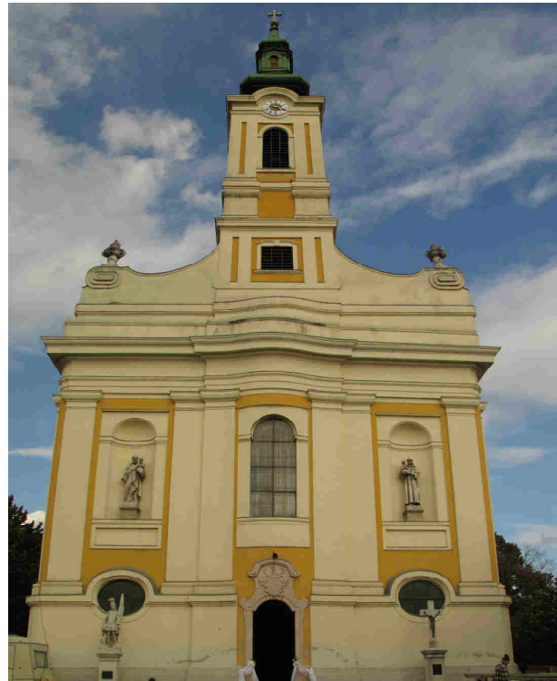
13. kép: A soroksári templom főhomlokzata(saját fotó)
