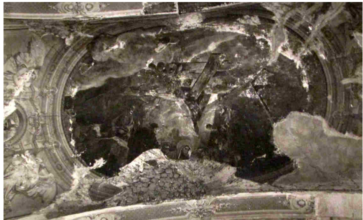
12. kép: A soroksári templom boltozata a földrengés után (Forrás: HDSS)
