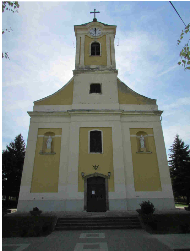
40. kép: A boldogi templom főhomlokzata (saját fotó)
