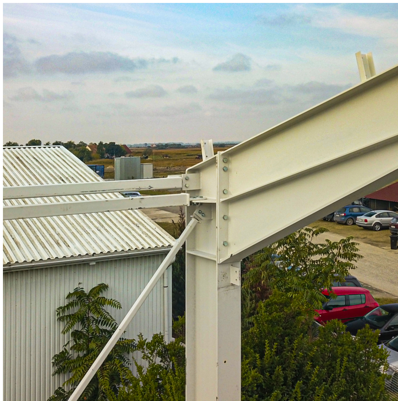
19.ábra – Építés során elkészült szerkezeti csomópont
