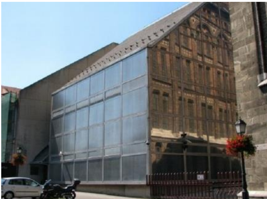
Országos Villamos Teherelosztó épülete 4
