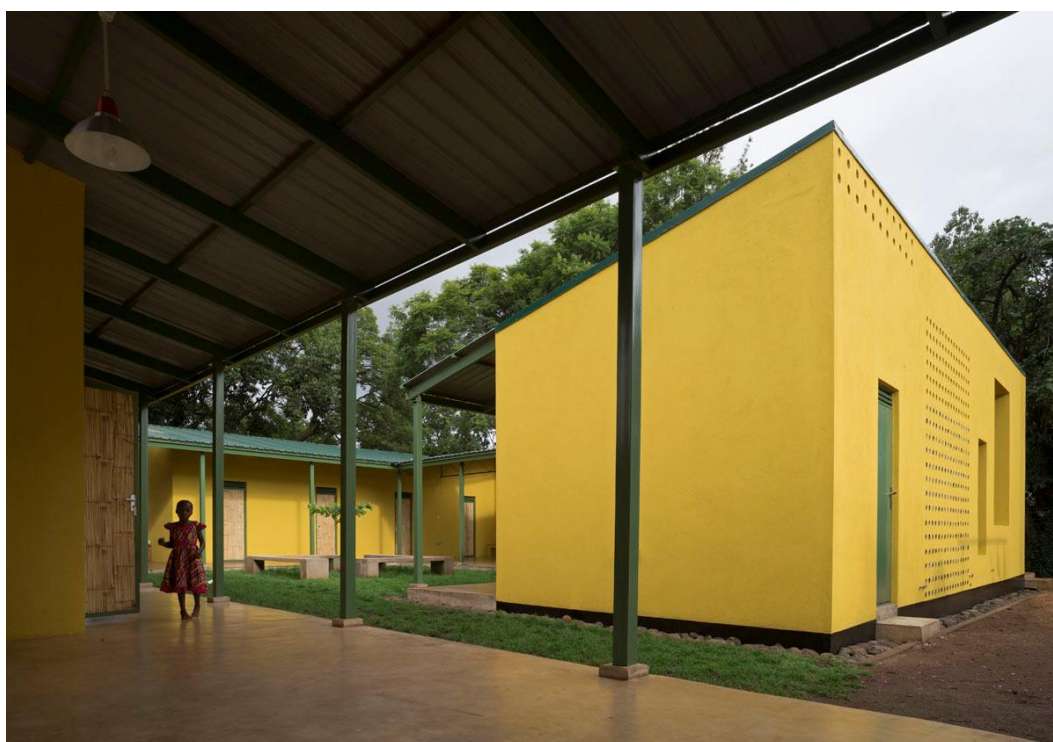
37. [Fig.] A homlokzat zárópárkány alatt megjelennek az átszellőztetett légrés kivezető nyílásai és a falba beépített vizesüvegek figyelhetőek meg.
