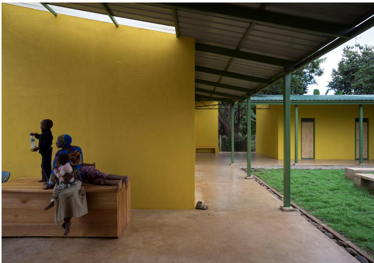
31. [Fig.] Túlnyúló eresszel fedett udvari közlekedők.
