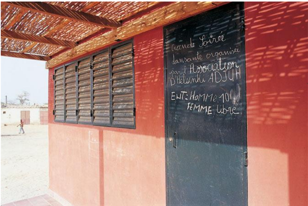
14. [Fig.] Túlnyúló, gyékényszőnyegből kialakított árnyékoló az utcai homlokzaton.
