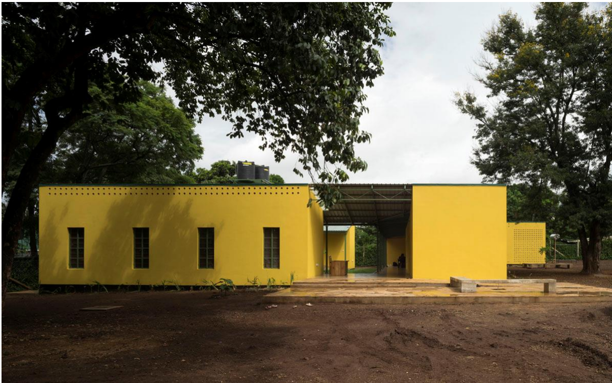
[Fig. 34]. Belső gyűrű felé orientálódó épületegyüttes. A köztes tereket fedett-nyitott módon alakították ki. A homlokzat zárópárkány alatt megjelennek az átszellőztetett légrés kivezető nyílásai.
