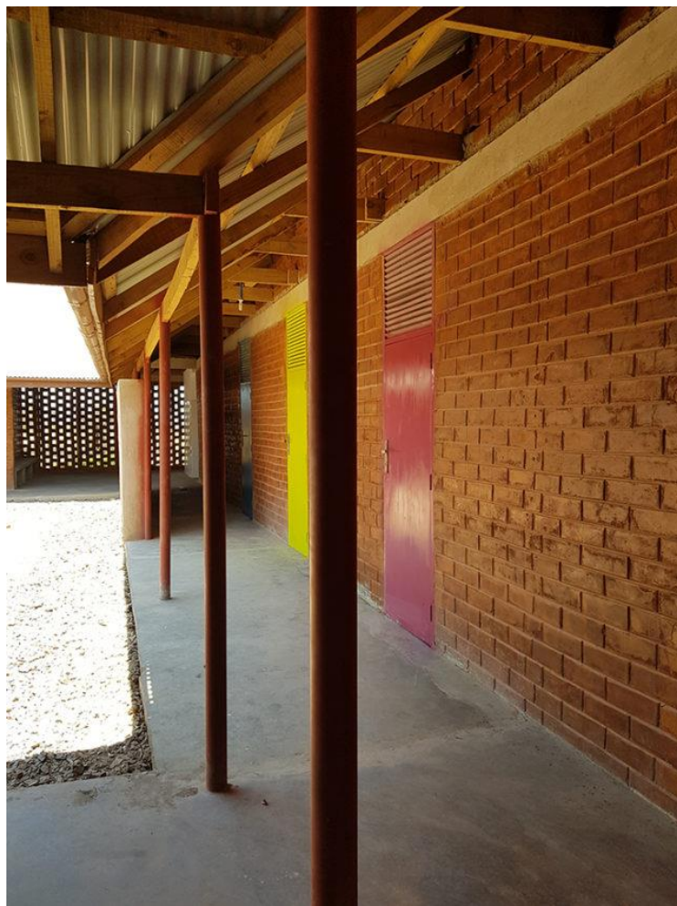
[Fig. 45] Megfigyelhető a szellőző nyílásokkal kialakított külső fal, és a túlnyúló eresz, illetve a későbbiekben bemutatott ISSB téglá (Nyang'Oro).
