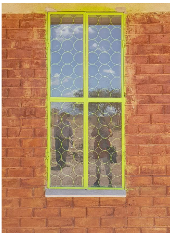
42. [Fig.] Újrahasznosított anyagokból készült nyílászáró az ISSB falban.
