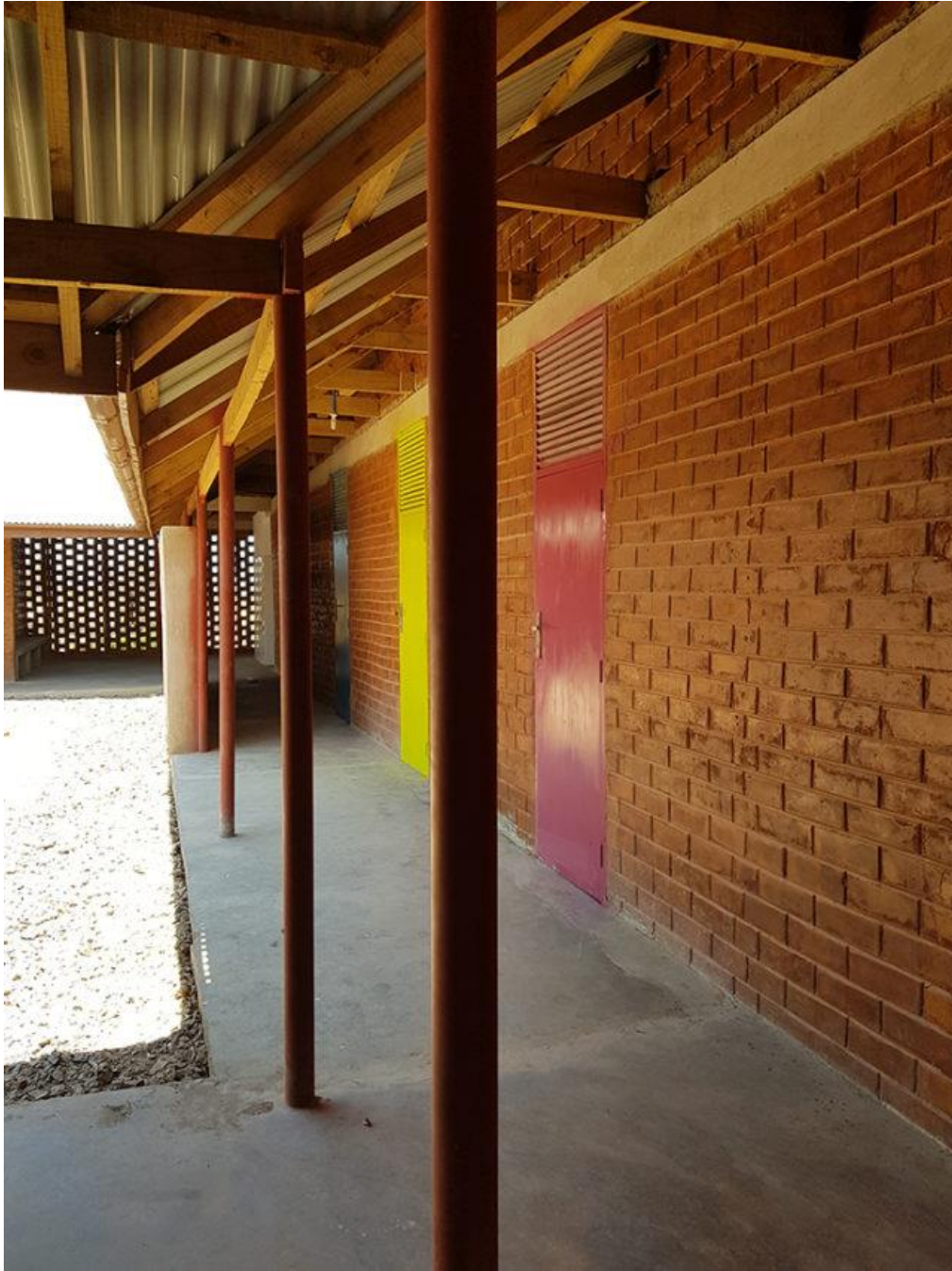
45. [Fig.] Megfigyelhető a szellőző nyílásokkal kialakított külső fal, a túlnyúló eresz és az ISSB fal.
