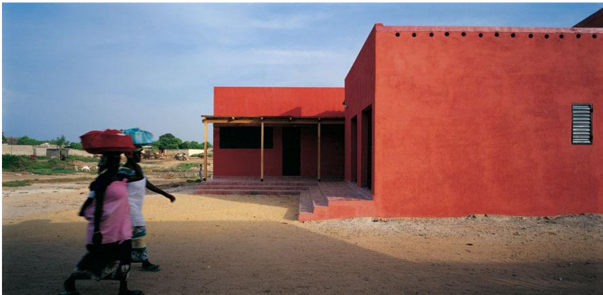
16. [Fig.] Kifelé zárt tömegalakítás. A nyílások kevés száma, a Nap elleni védelem mellett, a vagyonvédelmet is jelenti. Továbbá látható lábazati 40cm-es lépcsős kiemelés is és a homlokzaton megjelenő szellőző nyílások.
