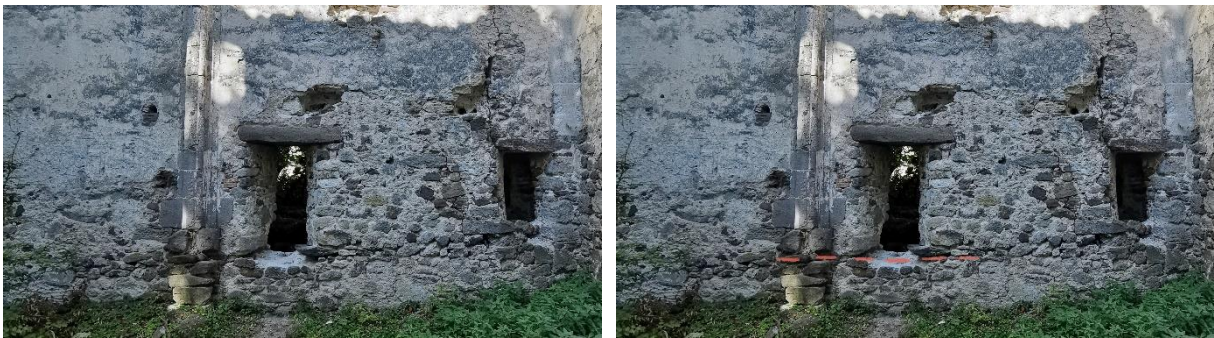
17. Az ajtónyílás és a pilaszter a hajó felől, jobbra a feltételezett padló vonalával
