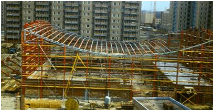
25. kép: A Székesfehérvári Sportcsarnok építése forrás: Hegyi Dezső archívuma
