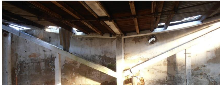
33. kép: a pala fedés néhol hiányos 2015.03.24.
