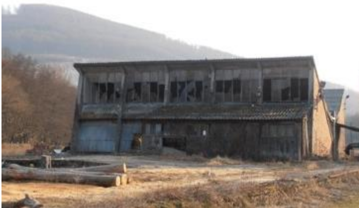
1. kép: A csarnok északkeleti homlokzata 2015.03.24.
