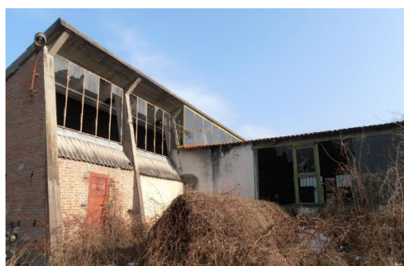
12.kép: belső tér, későbbi csarnok csatlakozása 2015.07.03.
