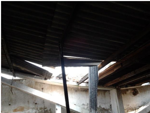
34.kép: leszakadt szelemen, beszakadt fedés 2015.08.16.
