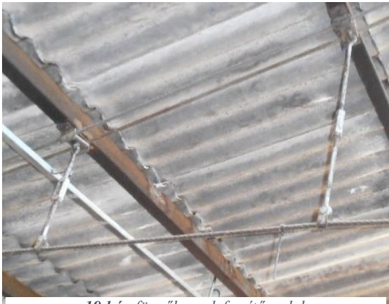
19.kép: függőleges lefeszítő rudak 2015.07.03.
