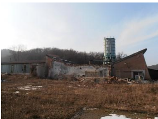
3. kép: A csarnok délkeleti homlokzata 2015.02.21.
