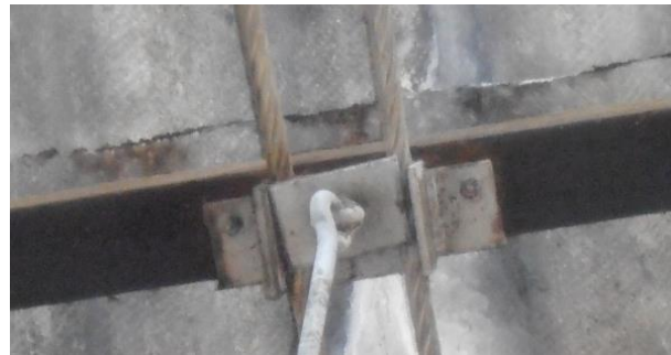
20.kép: tartókötél és függőleges lefeszítő kaps. 2015.07.03.
