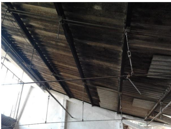
36. kép: tönkrement feszítő rúd 2015.08.16.
