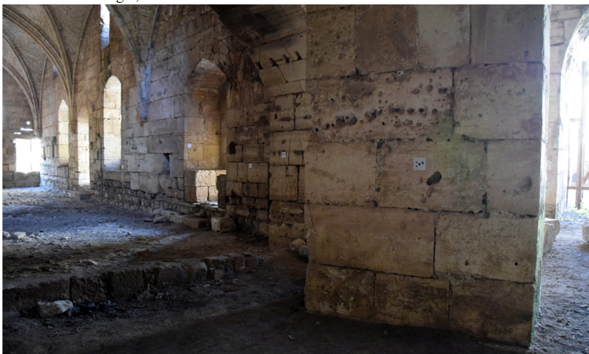
50. ábra: A kiragasztott markerek nagyban segítik a modell későbbi léptékezését, illesztését
