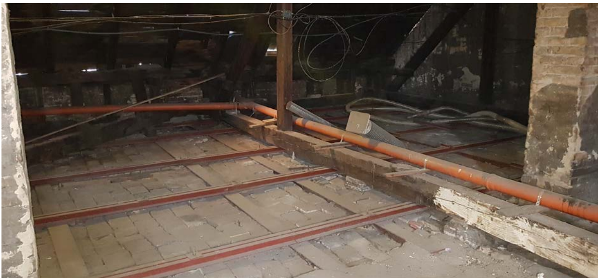
A PVC csatornarendszer. Fotók: Kozák Ágnes
