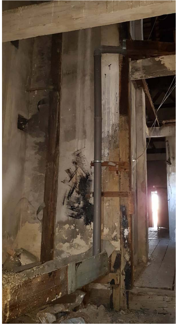
A csatorna csatlakozása a befolyási ponthoz. Kétszintes csatorna. Fotók: Kozák Ágnes
