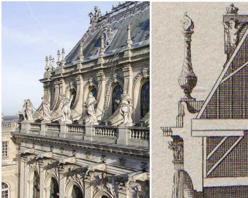
A Versailles-i kastély kápolnája. Attikafal balusztrádokkal, vízköpők. Forrás:chateauversailles.fr; Metszet részlete az eresznél. Forrás:Lepautre, Pierre: Les Plans, Coupes, Profils Et Elevations De la Chapelle du Chateau Royal de Versailles
