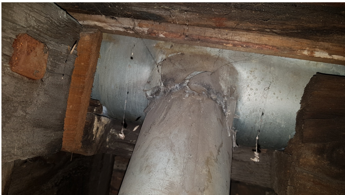
Hegesztett csatlakozás. Fotó: Kozák Ágnes
