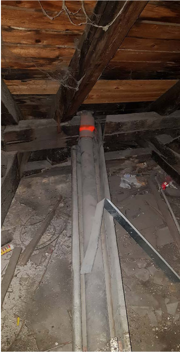
A csatorna csatlakozása a befolyási ponthoz. Kétszintes csatorna. Fotók: Kozák Ágnes
