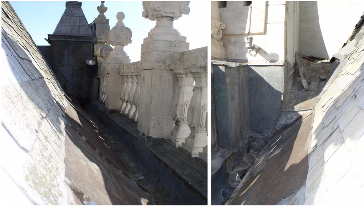
A meglévő csatorna kritikus helyei. Fotók: Dobszay Gergely
