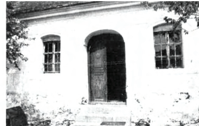
Vöröstó, Fő u.43.sz.ház bejárati homlokzata
