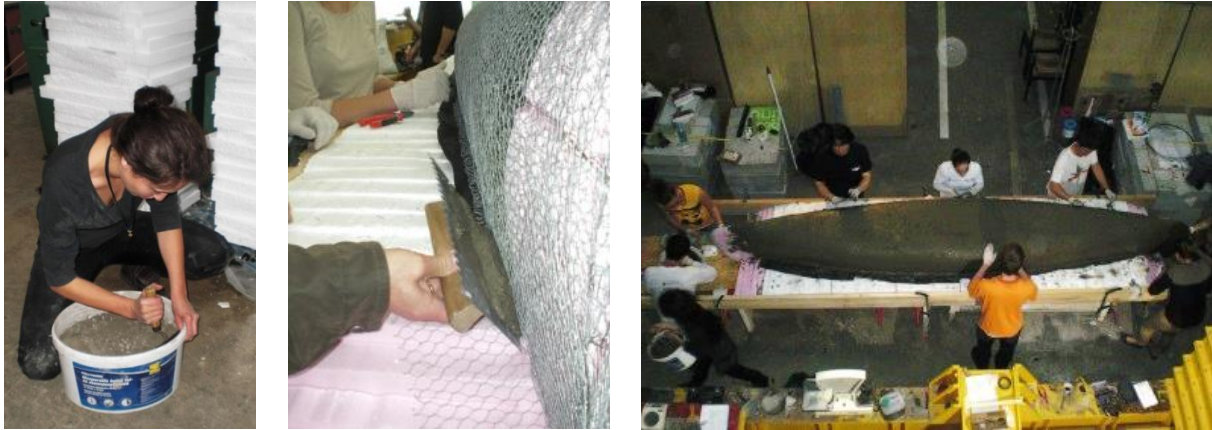
13. képsor: A betonozás részletei
