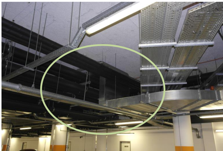
6.4. ábra: Légtechnikai csatorna iránytörése a keresztvezető csőkötegeknél (kép készült: 2013. 05. 24.)
