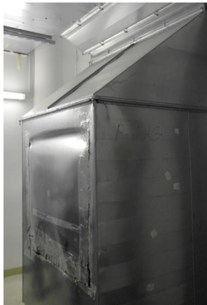
6.6. ábra: Légtechnikai berendezés utólagos átalakítása (kép készült: 2013. 05. 24.)
