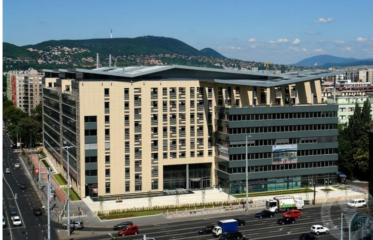
6.2. ábra: Capital Square épülete a Váci út és Dráva utca sarkáról [irodahaz.info]
