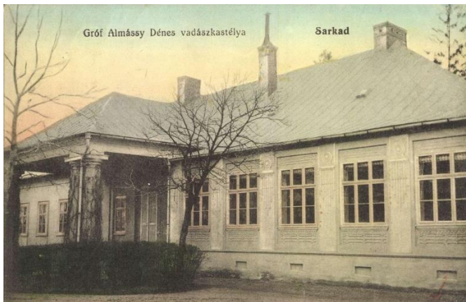
28. kép: Az átalakított homlokzat
