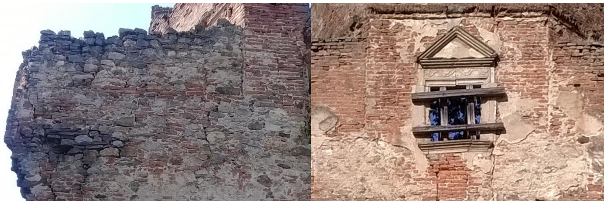
1. kép A kaputorony és az emelet falának csatlakozása az udvar felől. saját fotó
