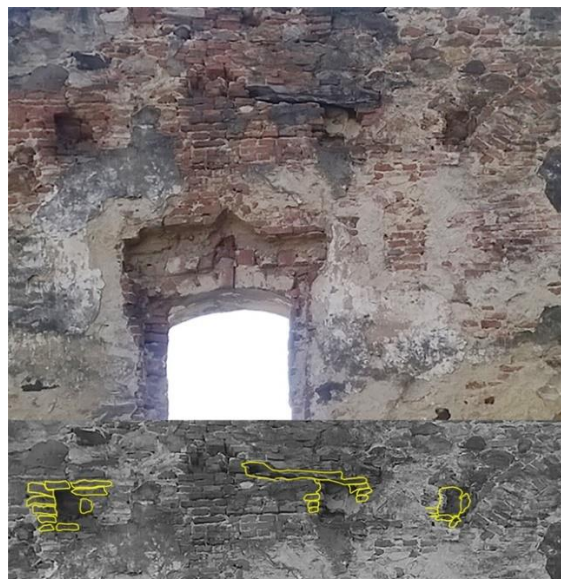
30. kép Az egykori tornác tetőszerkezetének helye a déli udvari homlokzat falában. saját fotó
