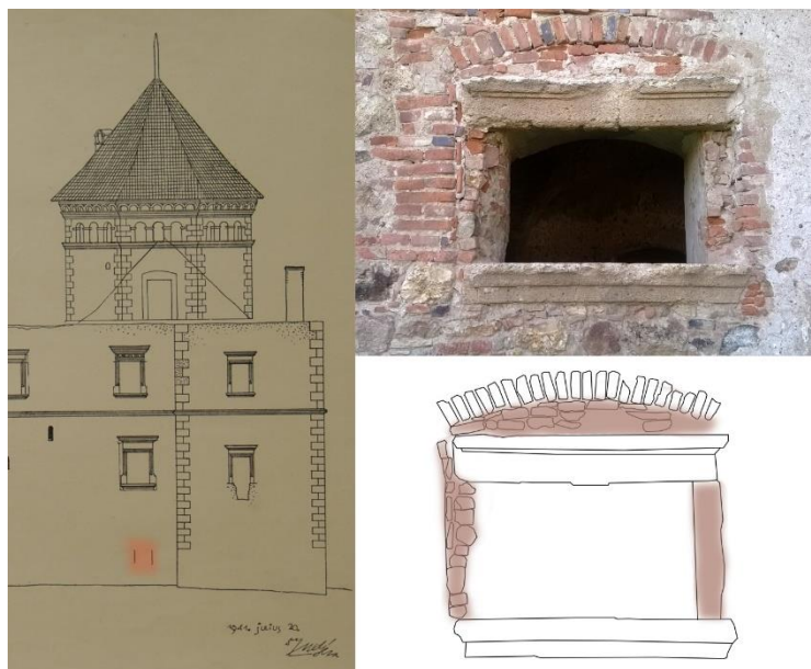
53. kép Befalazott és újból kibontott ablakkeret az aranyosmeggyesi kastély északi homlokzatának földszintjén. BME Építészettörténeti és Műemléki Tanszék Rajz-és Fotótára [102416] részlet, saját fotó és rajz.
