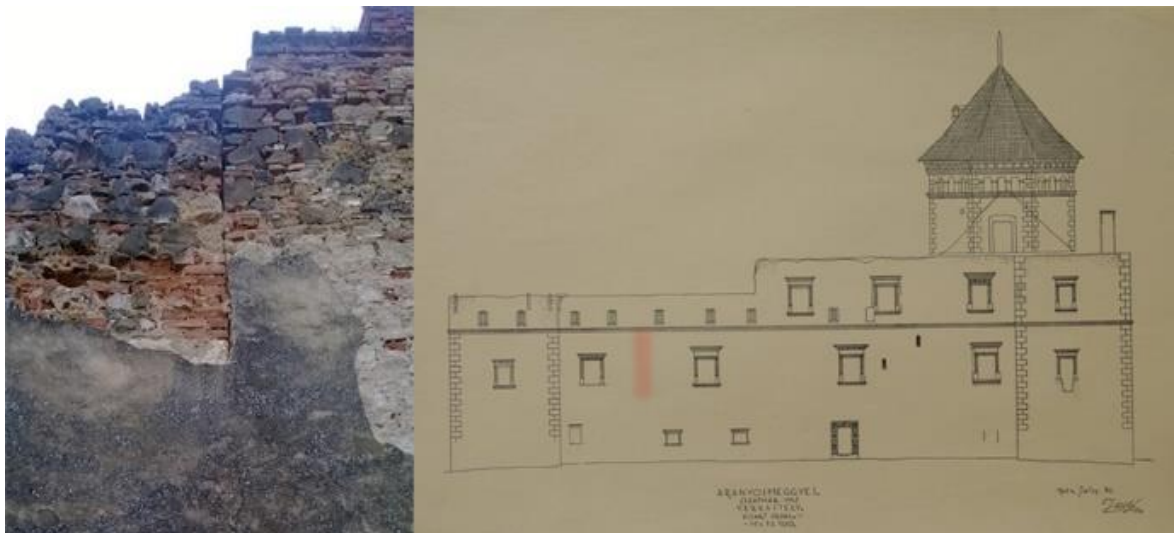
59. kép Függőlegesen elváló falazat az aranyosmeggyesi kastély északi homlokzatán. saját fotó és BME Építészettörténeti és Műemléki Tanszék Rajz-és Fotótára [102416]
