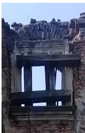
50. kép Ablakkeret és nyiláskiváltás az aranyosmeggyesi kastély északnyugati sarokbástyájának második emeletén. saját fotó és rajz
