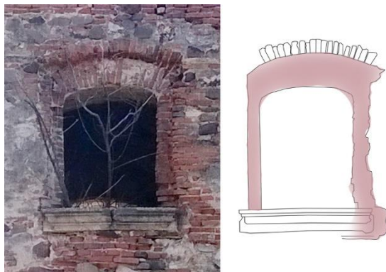
73. kép Ablakkeret egykori helye az aranyosmeggyesi kastély délnyugati sarokbástyájának első emeletén. saját fotó és rajz
