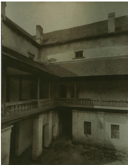
27. kép Az aranyosmeggyesi kastély belső udvara északnyugat felé nézve Hollenzer László fotóján. BME Építészettörténeti és Műemléki Tanszék Rajz-és Fotótára [801277]
