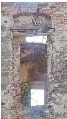
49. kép Ablakkeret helye és ablakkiváltás az aranyosmeggyesi kastély északnyugati sarokbástyáján. saját fotó és rajz
