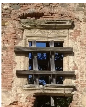
45. kép Ablakkeretezés és kiváltás a főhomlokzat első emeletén. saját fotó és rajz
