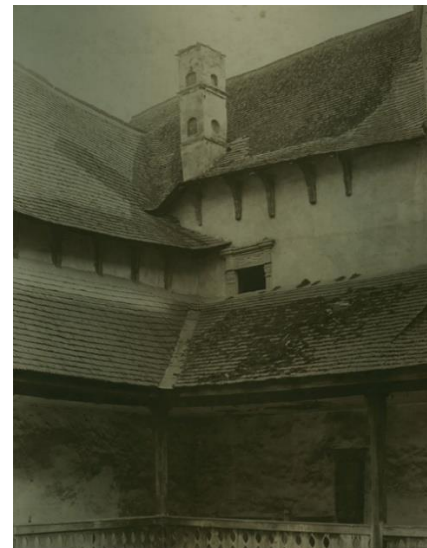
28. kép Az aranyosmeggyesi kastély belső udvara délnyugat felé nézve Hollenzer László fotóján. BME Építészettörténeti és Műemléki Tanszék Rajz-és Fotótára [201282]
