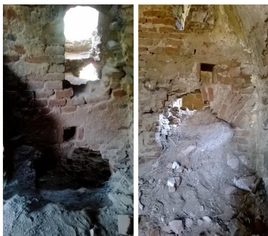
95. kép Fűtőnyílások két oldalról az aranyosmeggyesi kastélyban. saját fotók
