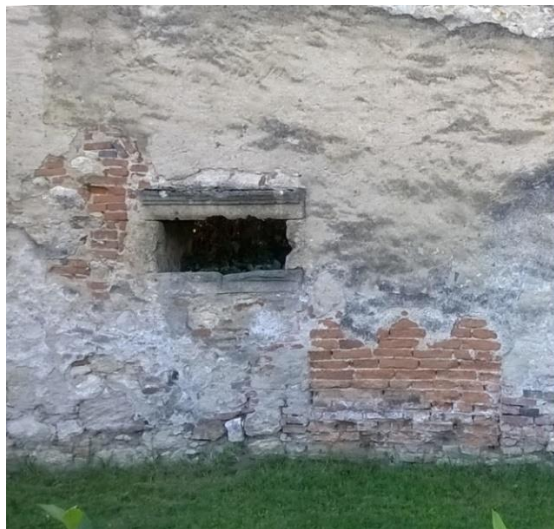
21. kép Befalazott nyílás az aranyosmeggyesi kastély északi homlokzatán. saját fotó
