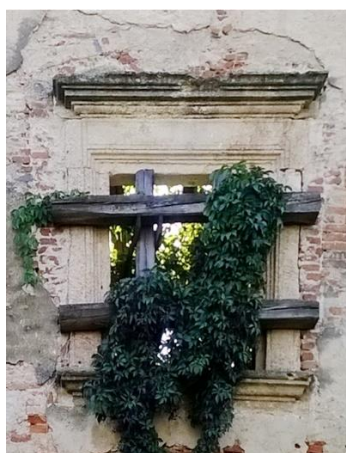
58. kép Ablakkeret és kiváltás az aranyosmeggyesi kastély északi homlokzatának első szintjén. saját fotó és rajz
