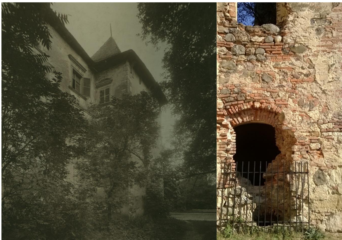
75. kép Nyíláskiváltás az aranyosmeggyesi kastély délnyugati sarokbástyájának földszintjén. BME Építészettörténeti és Műemléki Tanszék Rajz-és Fotótára [801283, saját fotó
