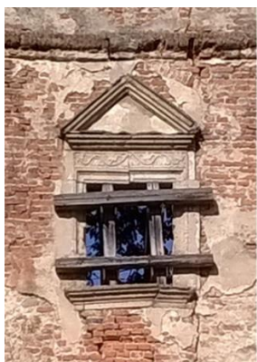
47. kép Ablakkeret és kiváltás a főhomlokzat második emeletén a kapu tengelyében. saját fotó és rajz
