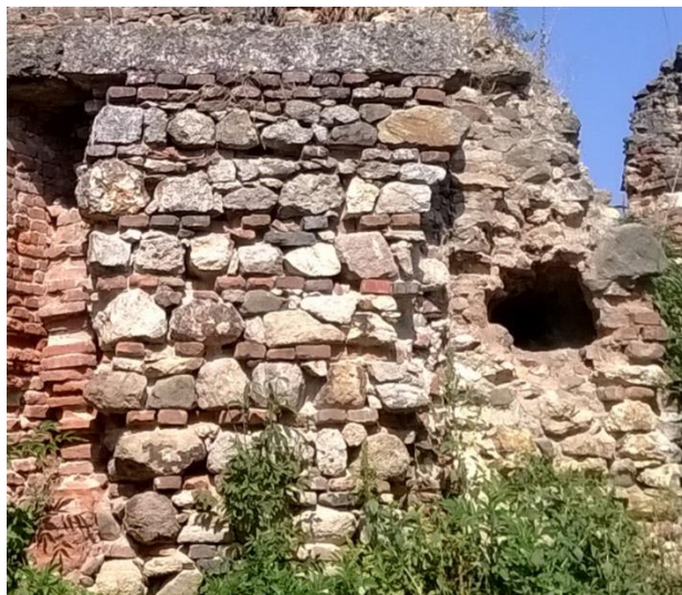
84. kép Utólag befalazott félköríves falfülke az aranyosmeggyesi kastély udvarának északi homlokzatán. saját fotó
