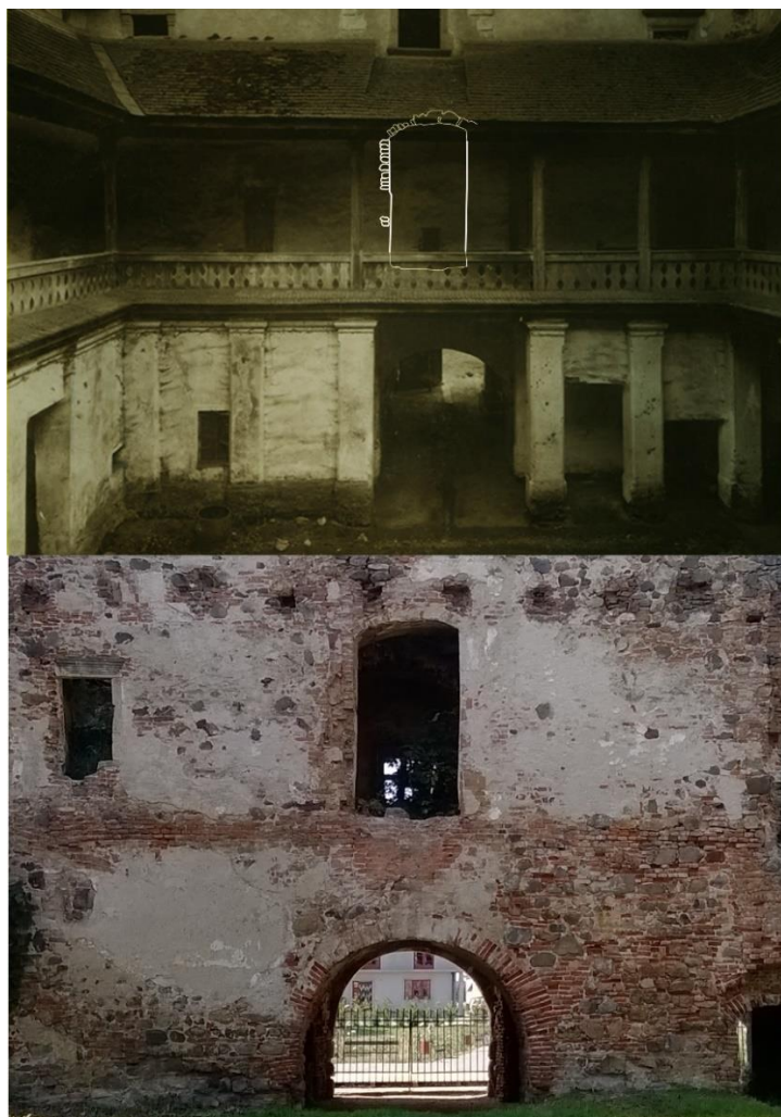
33. kép Az aranyosmeggyesi kastély udvari homlokzata nyugat felé Hollenzer László fotóján és jelenlegi állapotában. a felső kép alapja: BME Építészettörténeti és Műemléki Tanszék Rajz-és Fotótára [801281], az alsó kép saját fotó
