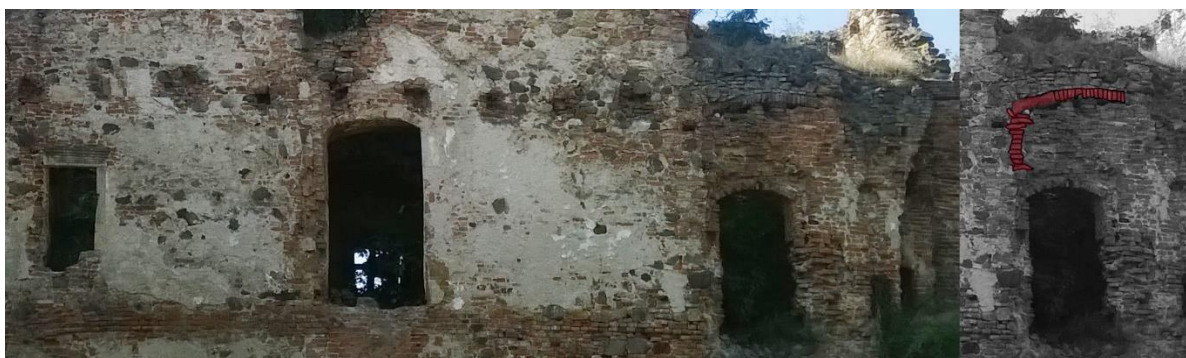
77. kép Szegmensív a falszövetben az aranyosmeggyesi kastély udvarának nyugati homlokzatán. saját fotó
