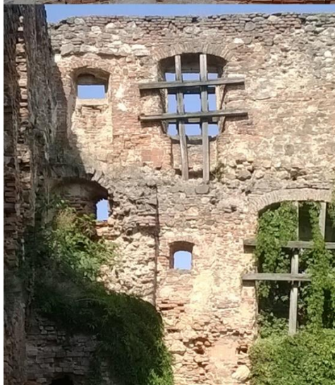
55. kép Kisméretű nyílások az aranyosmeggyesi kastély északi homlokzatán. saját fotók
