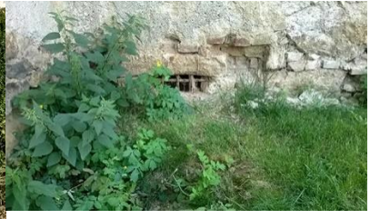
20. kép Egykori pinceablak az aranyosmeggyesi kastélyban az északnyugati sarokbástya keleti oldalán. saját fotó
