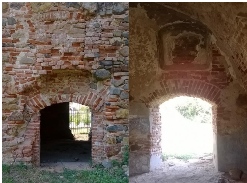
76. kép Ajtó és befalazott nyílás az aranyosmeggyesi kastély udvarának nyugati homlokzatán, kívülről és belülről. saját fotók
