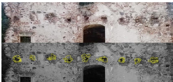
31. kép Az egykori tornác tetőszerkezetének helye a nyugati udvari homlokzat falában. saját fotó
