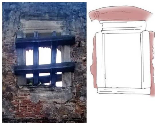
61. kép Ablakkeret és kiváltás az aranyosmeggyesi kastély északi oldalának legfelső emeletén. saját fotó és rajz
