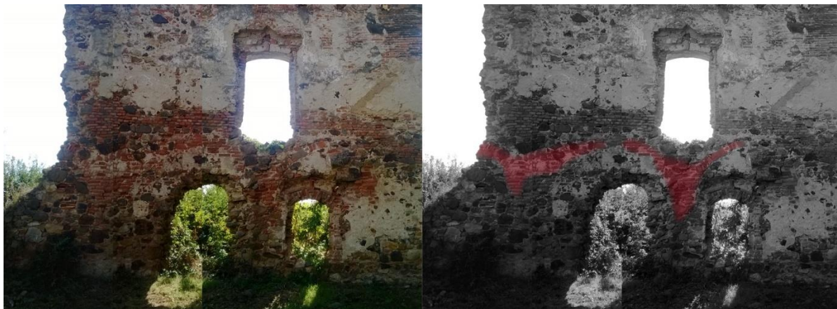
80. kép Ívek a falszövetben az aranyosmeggyesi kastély udvarának déli homlokzatán. saját fotó
