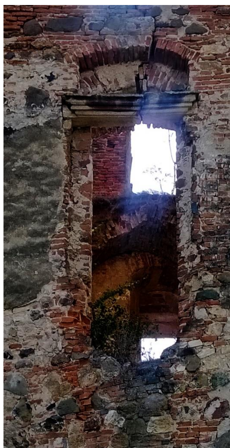
42. kép Nyíláskeret- és kiváltás az aranyosmeggyesi kastély északnyugati sarokbástyájának északi oldalán. saját fotó
