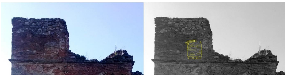
74. kép Befalazott nyílás az aranyosmeggyesi kastély délnyugati sarokbástyájának legfelső emeletén. saját fotó
