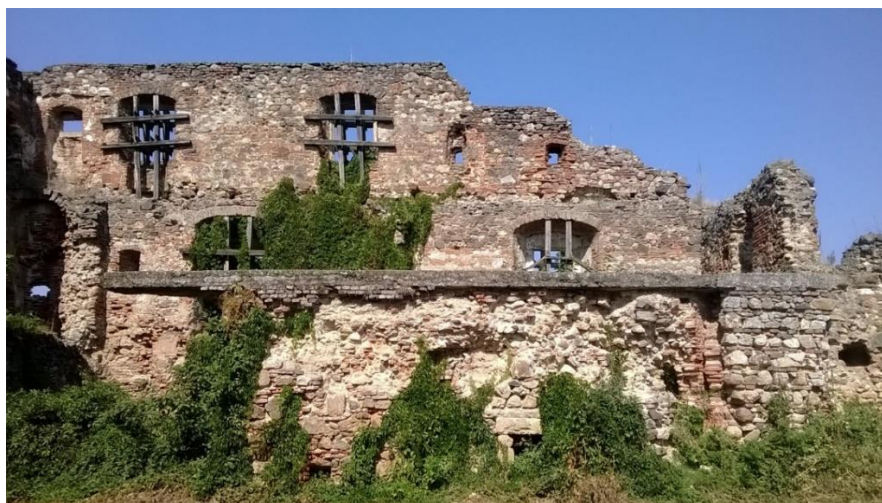
11. kép Az aranyosmeggyesi kastély északi homlokzata az udvarról nézve. saját fotó
