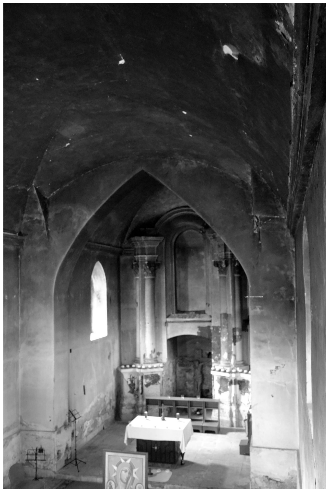
a belső tér jelenlegi állapota
