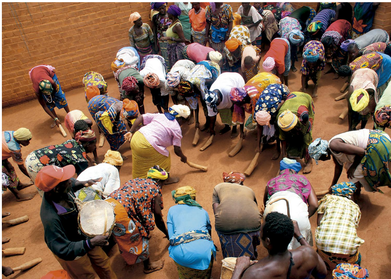
4. kép: Gandoi általános iskola döngölt padlójának készítése
