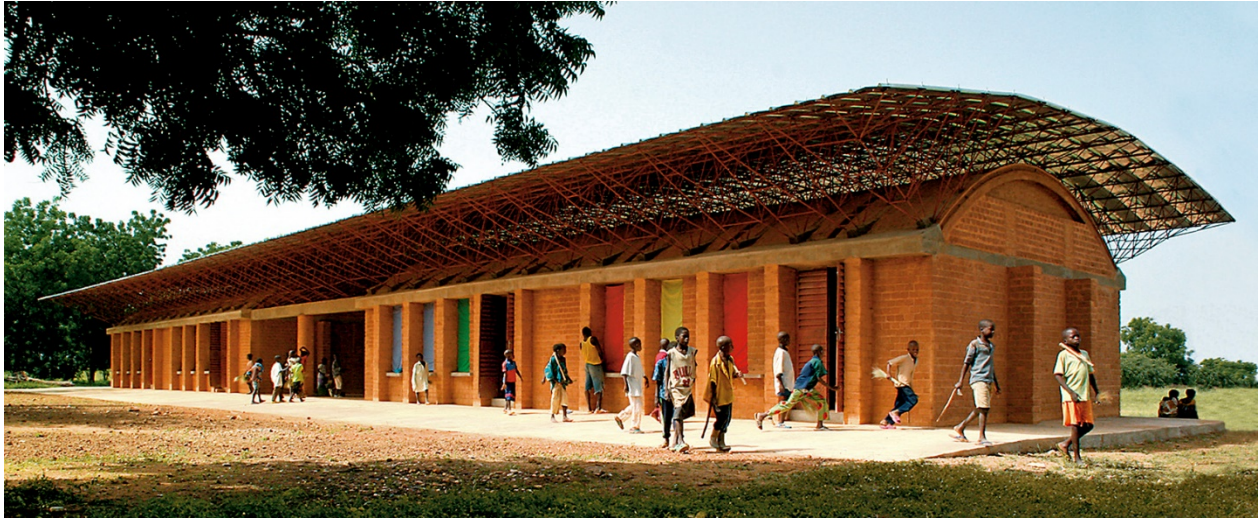
3. kép: Gandoi általános iskola bővítése
