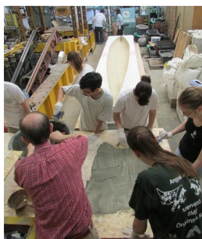
5. kép: A beton bedolgozása az üvegszövet hálóba
