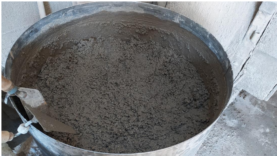
4.1. ábra Kényszerkeverő, benne friss betonnal
