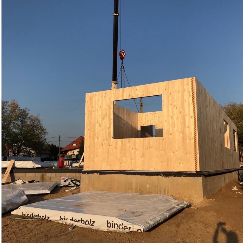
2. ábra. X-LAM panelekből épülő ház Veresegyházon ( azenfam.hu/galeria ).
